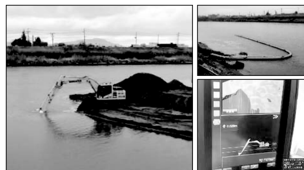
図-5 マシンコントロールバックホウと汚濁防止フェンス
