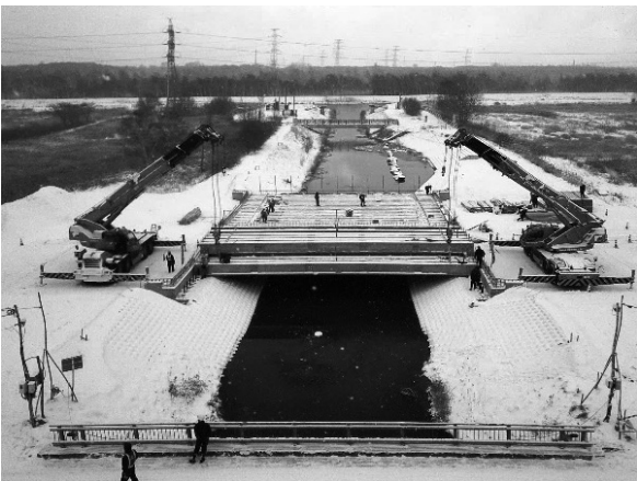
図-5 架設状況 ステップ3
