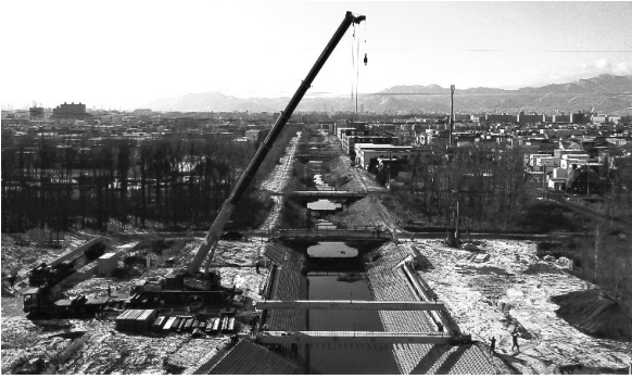
図-4 架設状況 ステップ1
