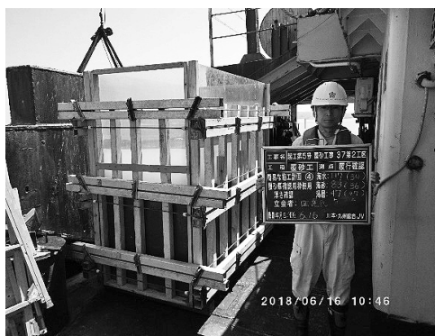
図-3 透明型枠全景
