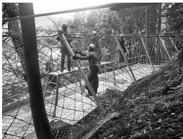
図-1 雪崩予防柵組立状況 (スノーネット)
