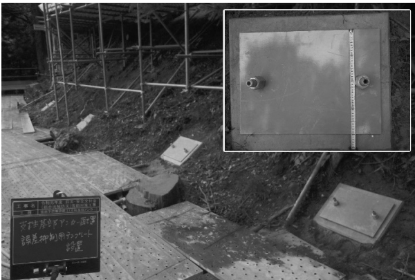
図-8 アンカー固定用テンプレート設置
