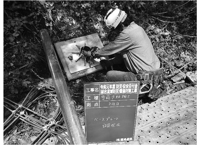
図-9 支柱基部プレート設置
