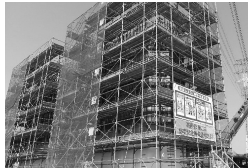
図-10 サーモフィッター設置全景
