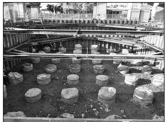
図-6 床付け完了状況 (P6)
