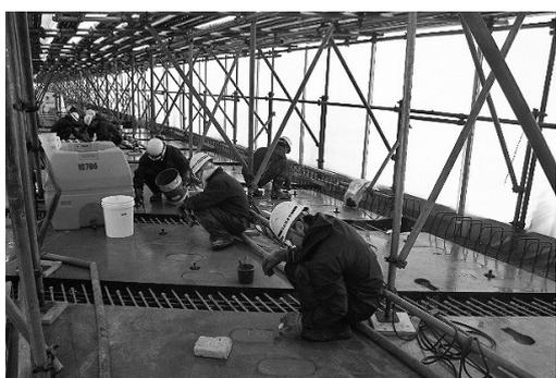
図-9 無収縮モルタル施工状況
