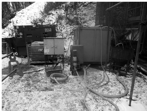
図-5 パイプクーリング使用機械
