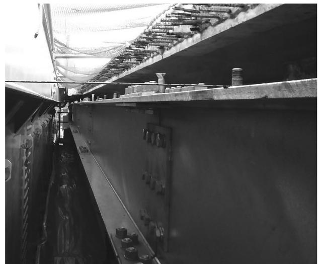
図-7 縦桁架設完了 (Bライン)
