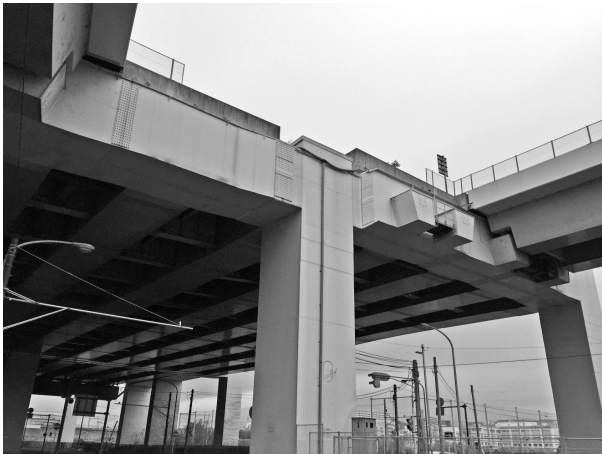
図-2 既設P1橋脚
