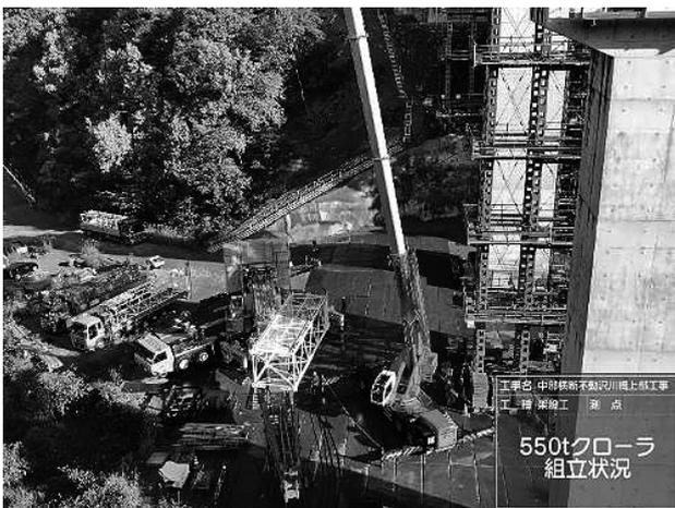
図-6 550tクレーン組立状況
