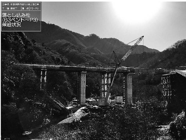
図-5 550t油圧クレーン架設状況
