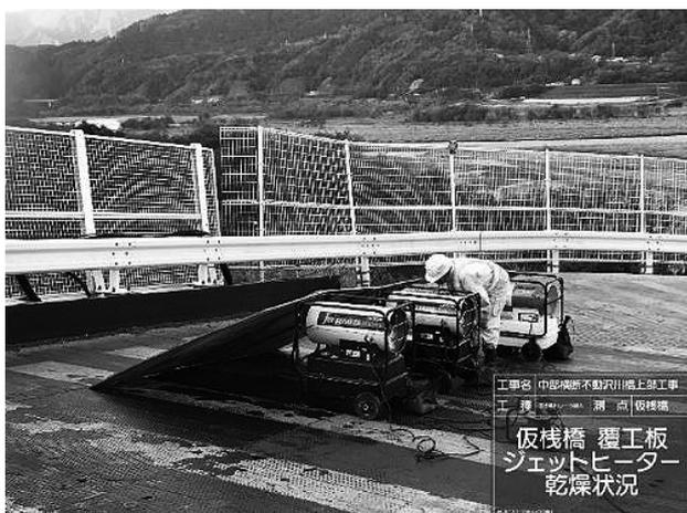
図-8 仮橋上のヒーターによる乾燥状況
