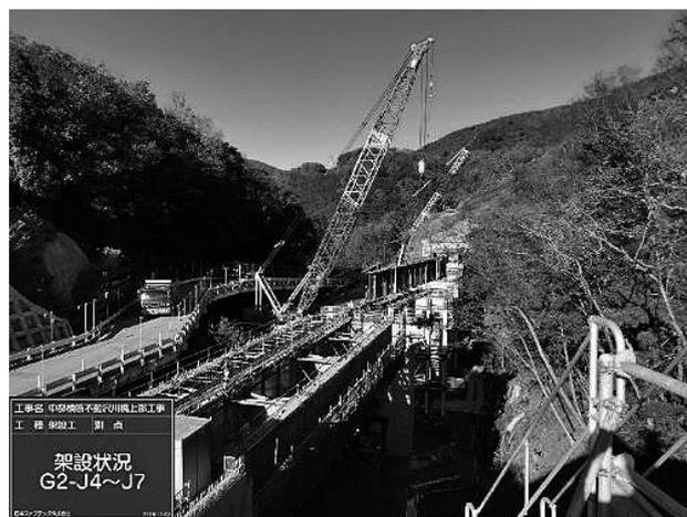
図-4 2班同時架設 (手前：仮栈橋上)
