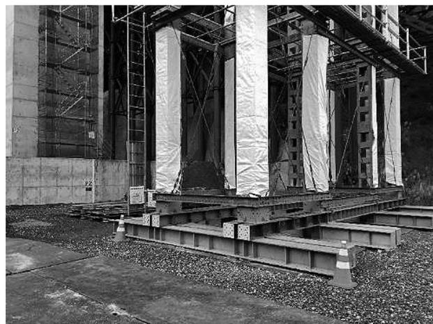
図-9 ベント基礎梁の延長状況
