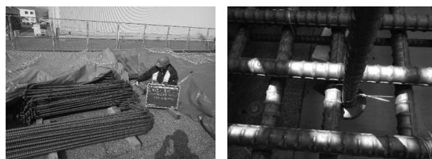
図-9 DBヘッドせん断補強鉄筋組立
