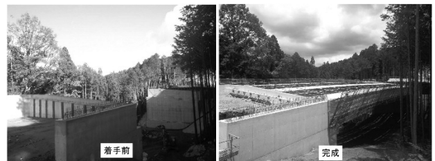
図-2 工事箇所全景
