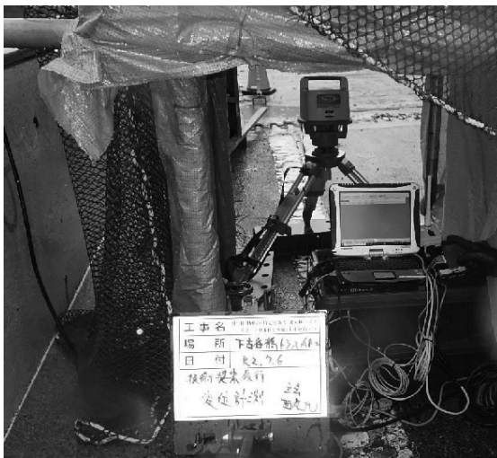
図-7 回転レーザーレベルの設置状況
