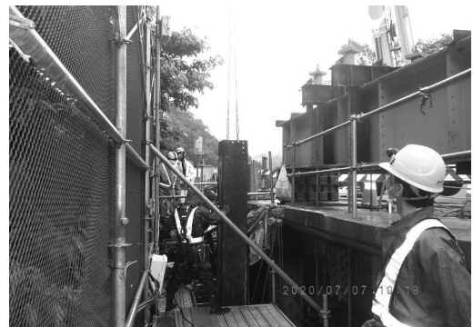
図-10 鉛直材取替の様子
