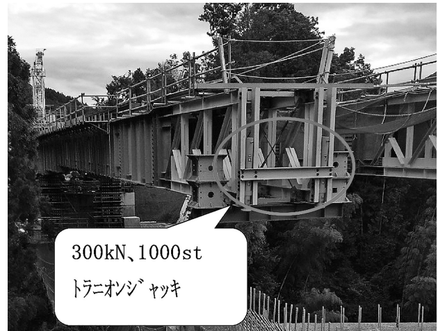
図-5 手延機先端設備
