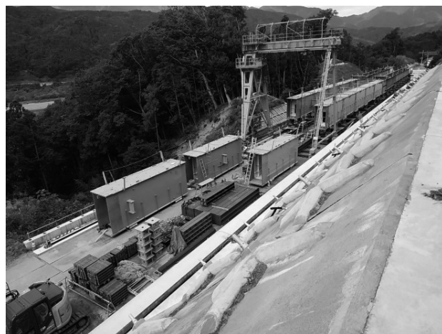
図-3 ヤード使用状況
