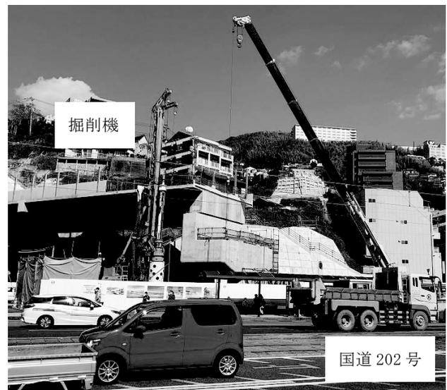
図-5 基礎杭設置状況
