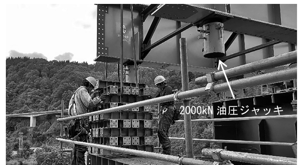
図-12 油圧ジャッキ吊り下げ状況
