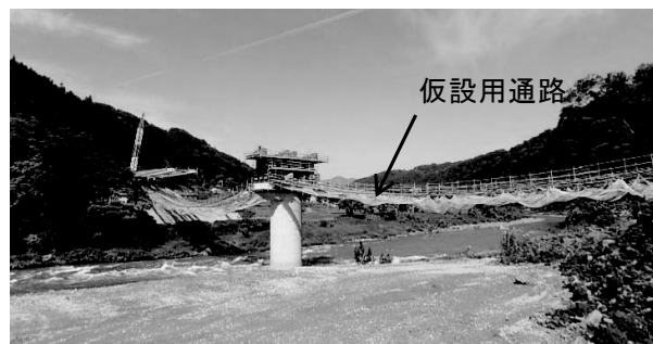
図-9 仮設用通路の設置
