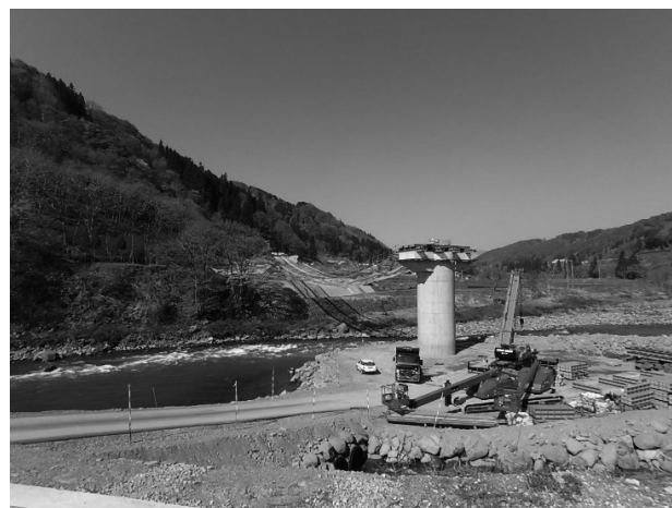
図-8 仮設備組立状況
