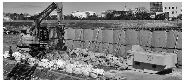
図-11 ニブラによる橋脚の破碎状況
