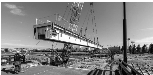
図-13 地組主桁の一括架設状況
