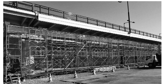
図-3 桁下全面足場設置状況
