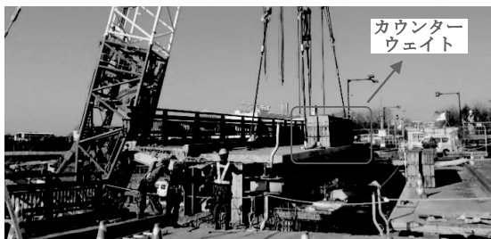
図-8 既設桁(主桁)撤去状況
