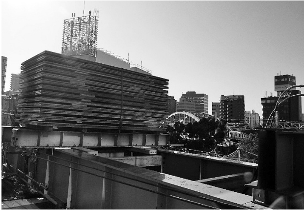
図-9 カウンターウェイト設置状況
