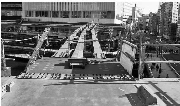
図-7 手延べ桁設置状況
