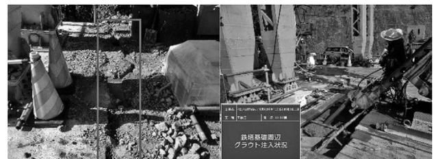
図-5 A1鉄塔基礎背面クラック発生
