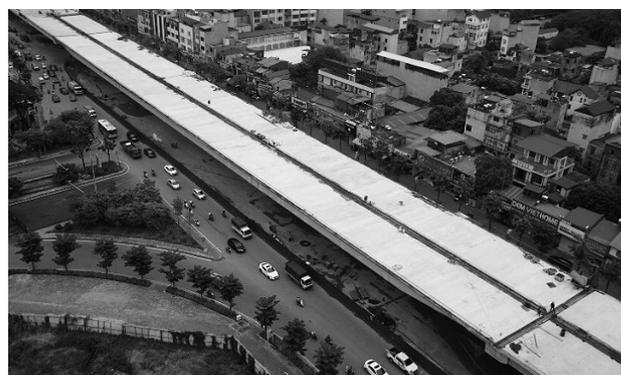
図-11 床版コン打設完了時全景
