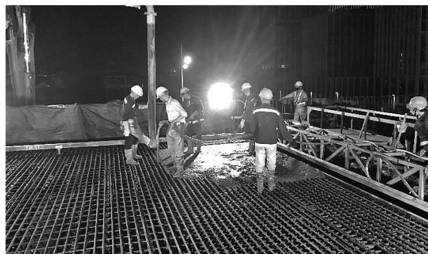
図-10 床版コンクリート打設状況
