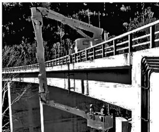
図-1 橋梁点検車による点検状況
