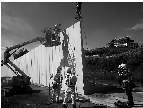
図-2 L型擁壁設置状況
