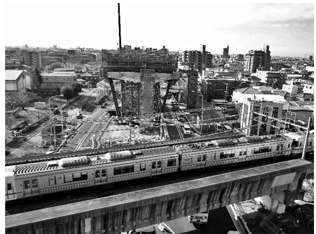
図-2 架設場所(発進側より撮影)
