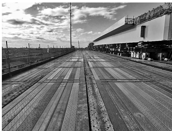
図-4 軌条設備上足場
