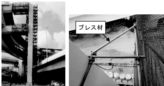
図-2 昇降設備全景と三角形の壁つなぎ
