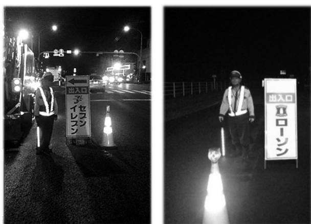
図-2 店舗の出入口看板と誘導員
