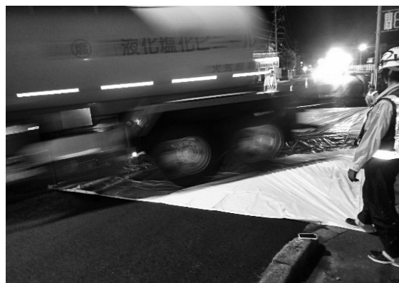
図-3 防災シートによる養生
