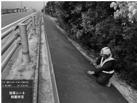
図-3 防草シート施工状況
