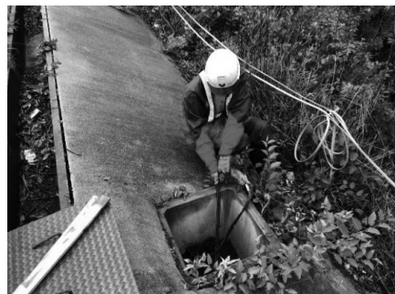
図-2 既設電線露出切廻し状況
