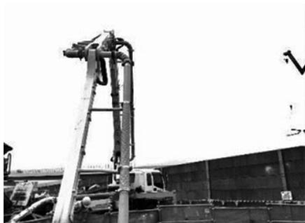
図-3 ポンプ車配管防護
