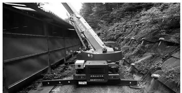
図-2 (5tクレーン設置状況)
