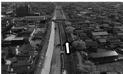
図-5 仮排水設置完了 (上空写真)
