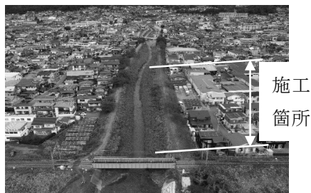
図-1 施工箇所上空全景着手前写真
