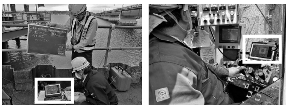
図-5 パイルナビ使用状況(1)
