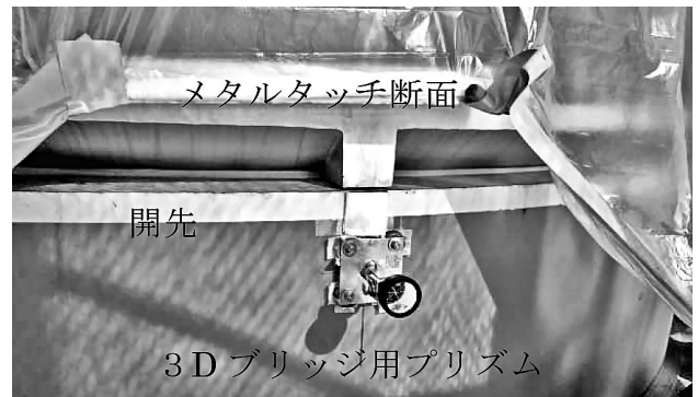
図-4 開先部メタルタッチ断面
