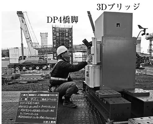
図-2 3Dブリッジによる計測状況
