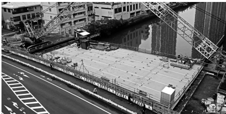
図-4 後期施工 桁架設状況
