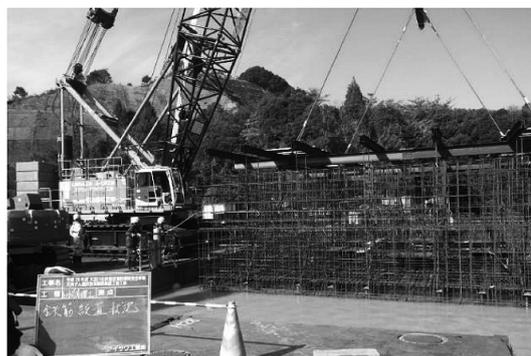
図-5 組立鉄筋据付状況
