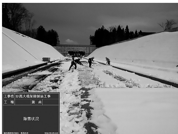
図-2 降雪時の除雪状況
