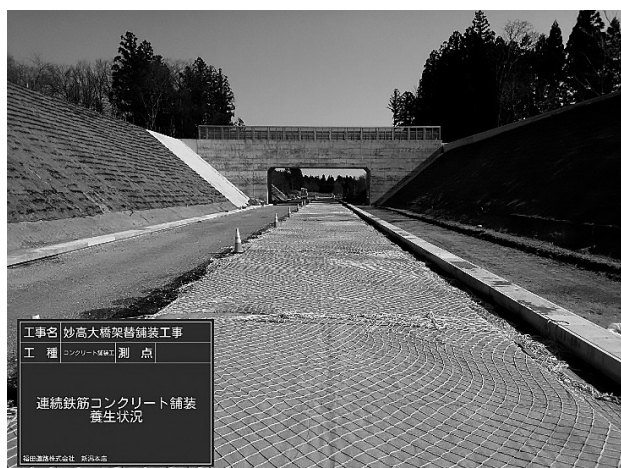
図-3 コンクリート養生保温シート使用
