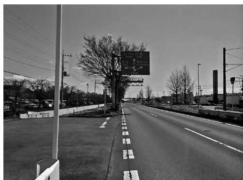
図-2 移設前の既設F型標識
