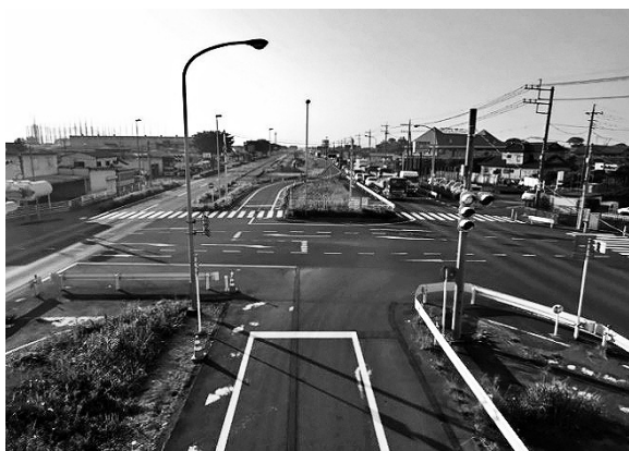
図-1 4車線での供用の様子
