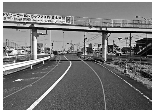
図-4 右折レーンの仮切り廻し
