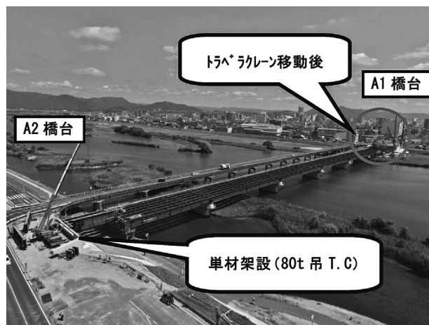
図-4 A2側単ブロック架設状況
