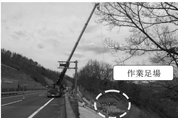
図-3 高速道路上からの資機材搬入
