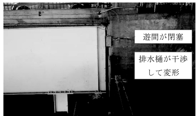
図-1 可動支承側遊間部
