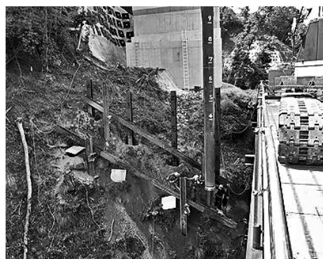
図-4 ベント基礎杭の施工状況
