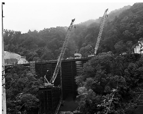
図-3 仮栈橋のクレーン使用状況
