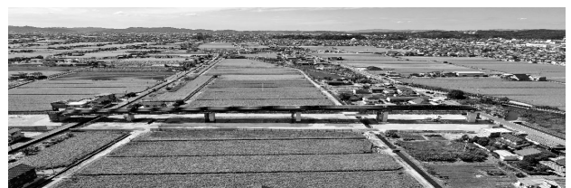
図-5 完成写真（G1桁側より撮影）
