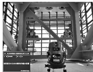
図-3 レーザーライン 図-4 横梁固定
