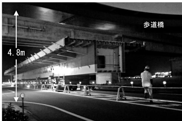
図-1 相吊り架設により一括架設
