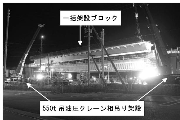
図-3 相吊り架設により一括架設
