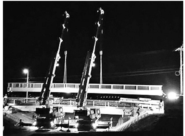
図-3 相吊りによる一括架設状況
