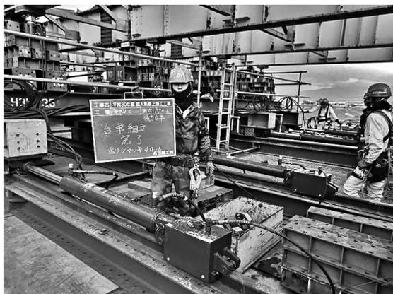
図-2 桁送り出し（台車）
