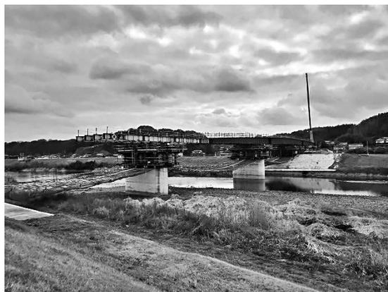
図-3 桁送り出し（全景）
