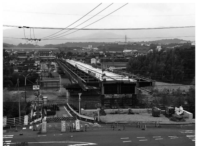
図-4 桁送出し完了
