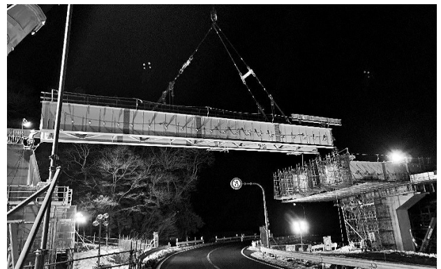
図-5 J31～GE2ブロック架設状況
