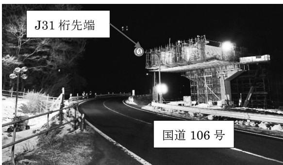
図-3 J30～J31ブロック架設完了後状況
