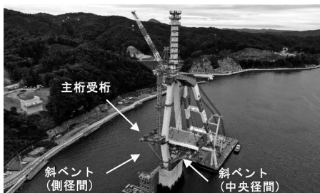
図-1 斜ベント上の架設状況
