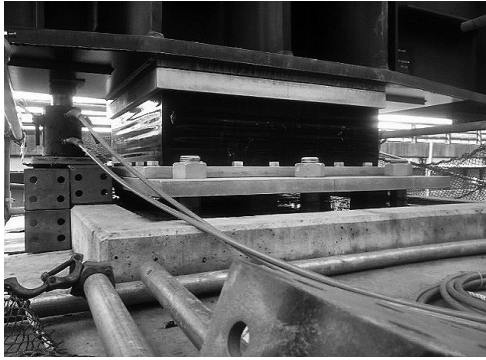
図-2 橋脚上ジャッキアップ設備
