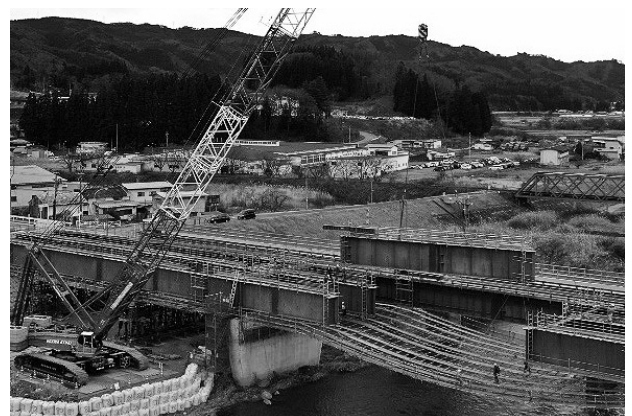
図-5 落とし込み架設状
