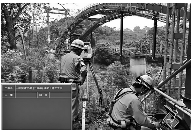
図-3 自動視準型3次元計測状況
