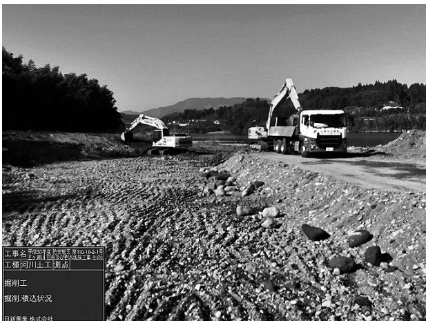
図-2 掘削・積込状況
