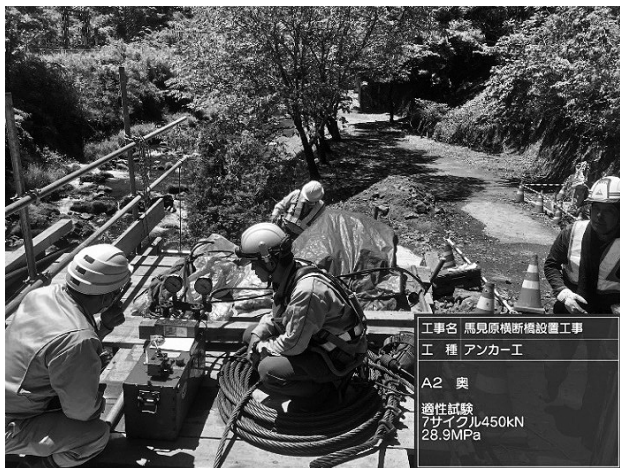
図-3 適正確認試験、アンカー定着状況
