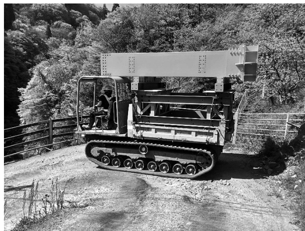
図-4 キャリーダンプ運搬状況
